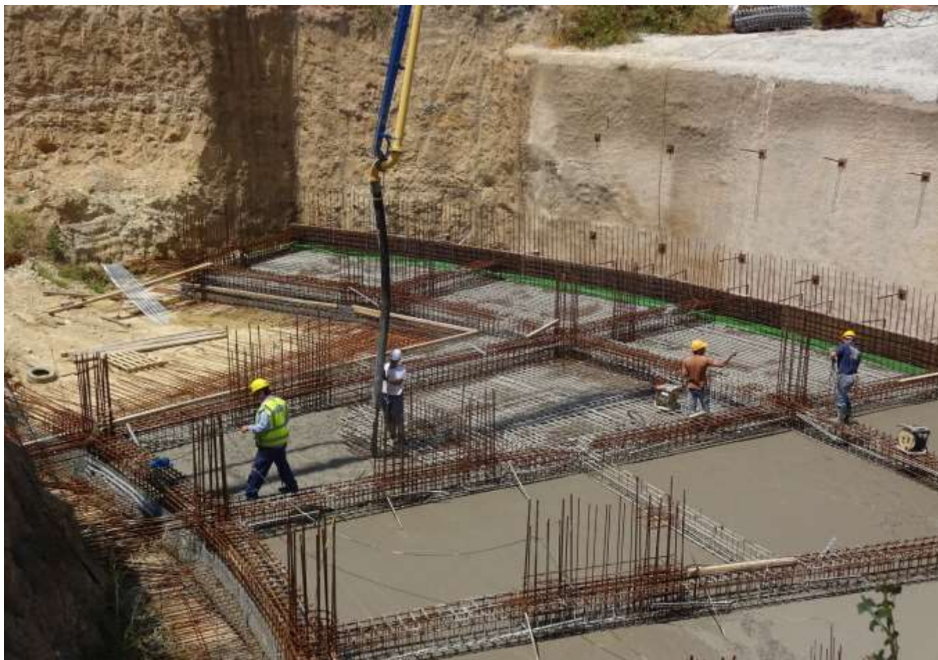
Στιγμιότυπο από τη σκυροδέτηση του πρώτου τμήματος θεμελίωσης του Βιοκλιματικού κτιρίου
